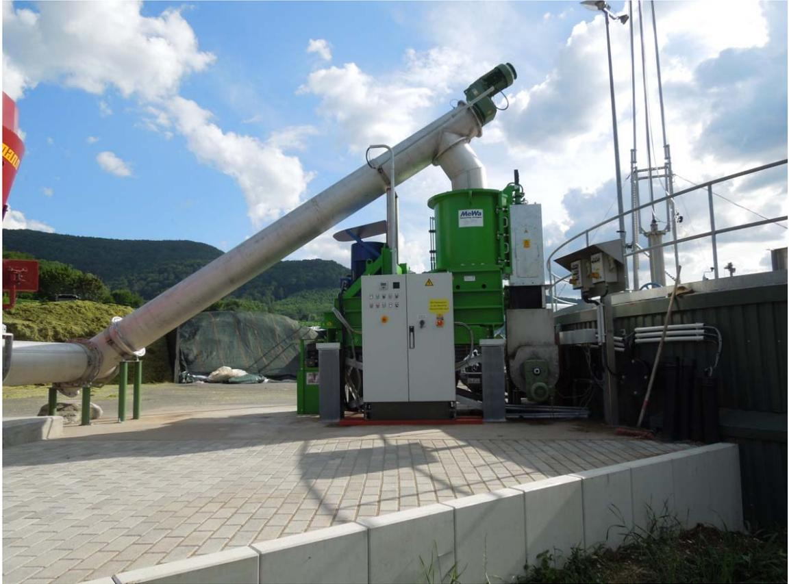
Abbildung 31: Installierter Bio-QZ am Fermenter 1 der Biogasanlage
