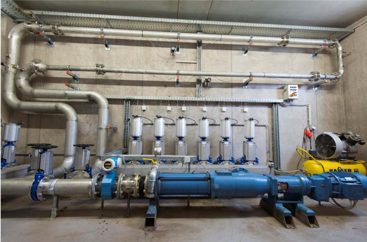
Abbildung 38: Inline-Viskosimeter an der Forschungsbiogasanlage mit den zwei Messstrecken.
