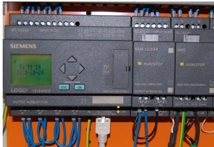
Abbildung 23: „Siemens Logo“ Steuerung mit LOGIKMODUL und Erweiterungsmodule, für digitale Ein- und Ausgänge und Analogeingänge
