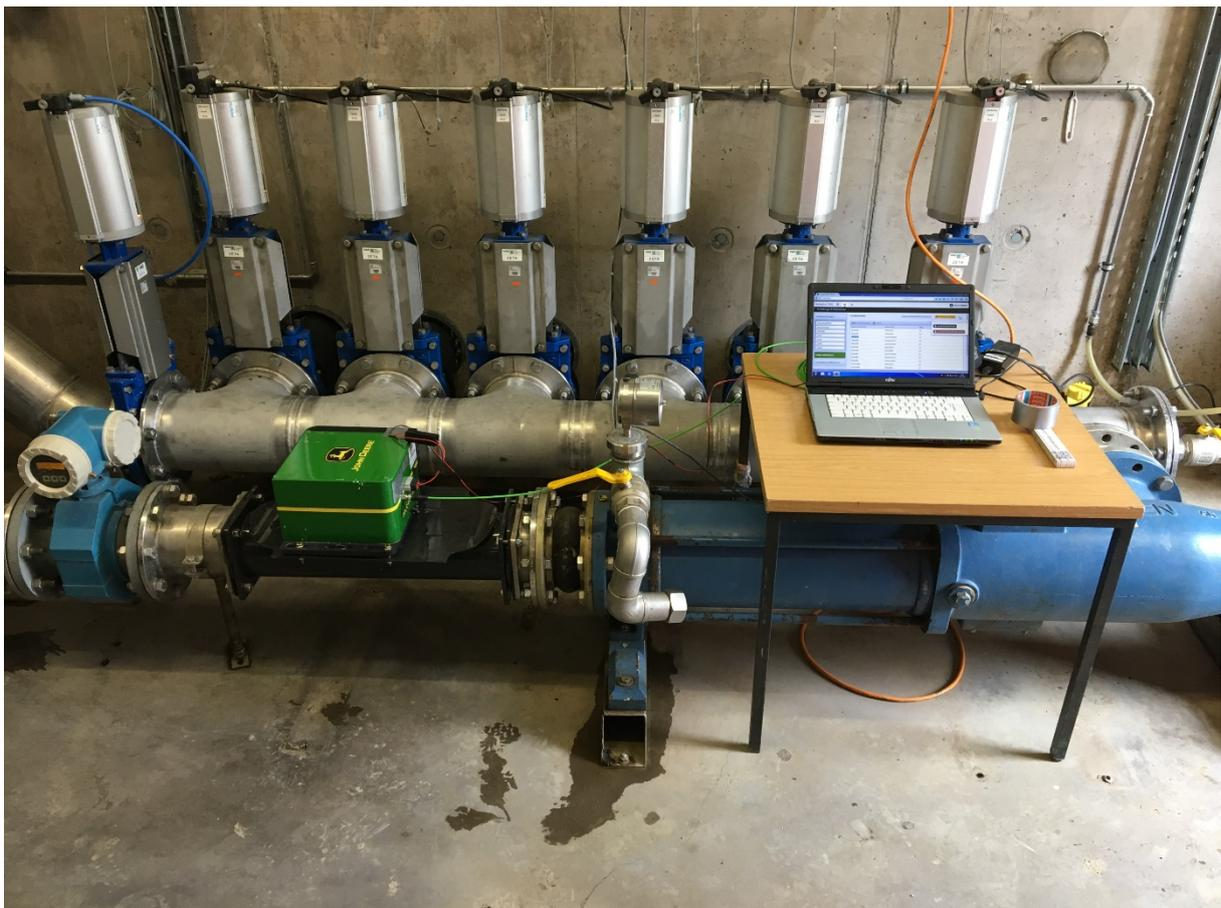
**Abbildung 17: NIRS-Sensor eingebaut in Pumpstation**
