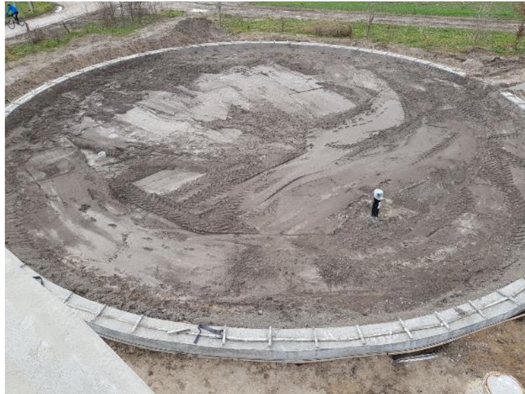
Abbildung 7 Fundament externer Gasspeicher (Baur Folien GmbH)
