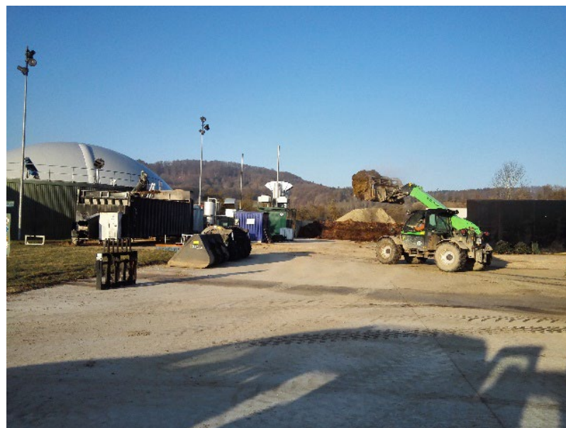
Biogasanlage mit Aufbereitung von Wirtschaftsdünger
