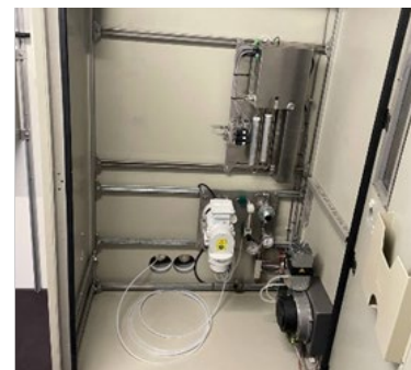
Messung der Gaskomponenten direkt an Fermenter mit neuer Sensortechnik. Rechts ist das installierte UV-Spektrometer zu sehen.
