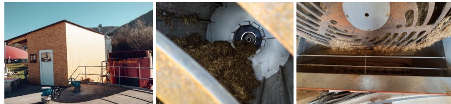
Kugelmühlen-Prototyp an der Forschungsbiogasanlage „Unterer Lindenhof“
