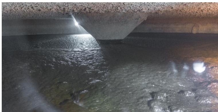
Die Biogaszusammensetzung wird direkt im Fermenter gemessen, um frühzeitig auf Prozessstörungen reagieren zu können
