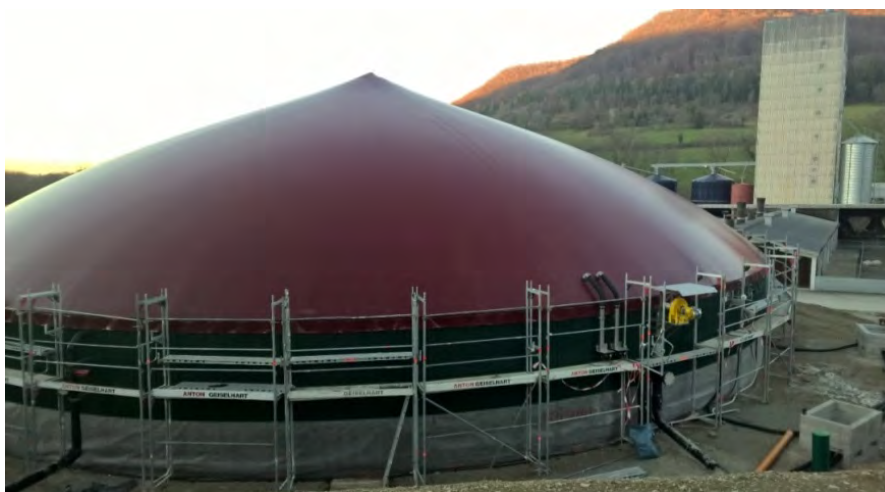
Das neue Gärrestlager während der Bauphase
