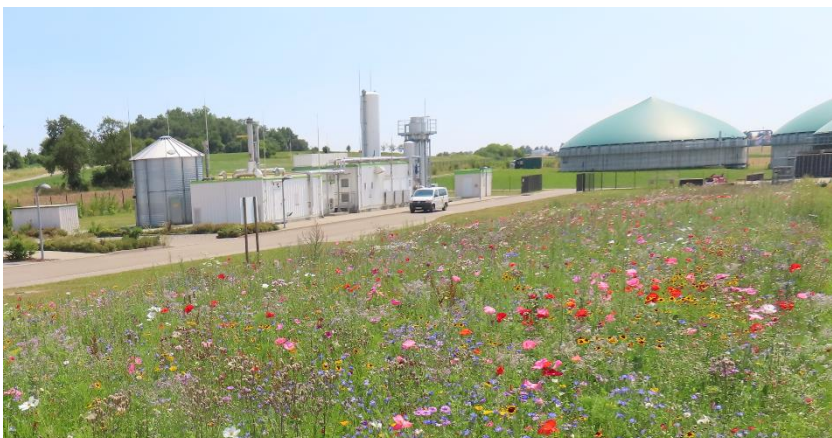
Biomethane upgrading plant (Erdgas Südwest)
