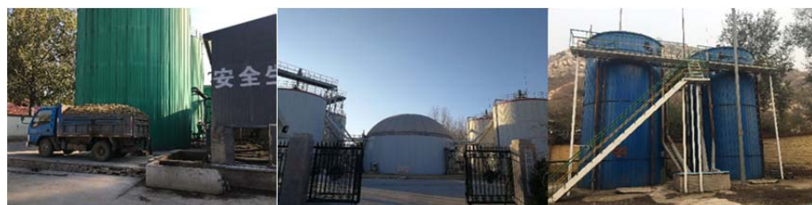
Die drei Anlagen des chinesischen Biogasmessprogramms (Oktober 2017)
