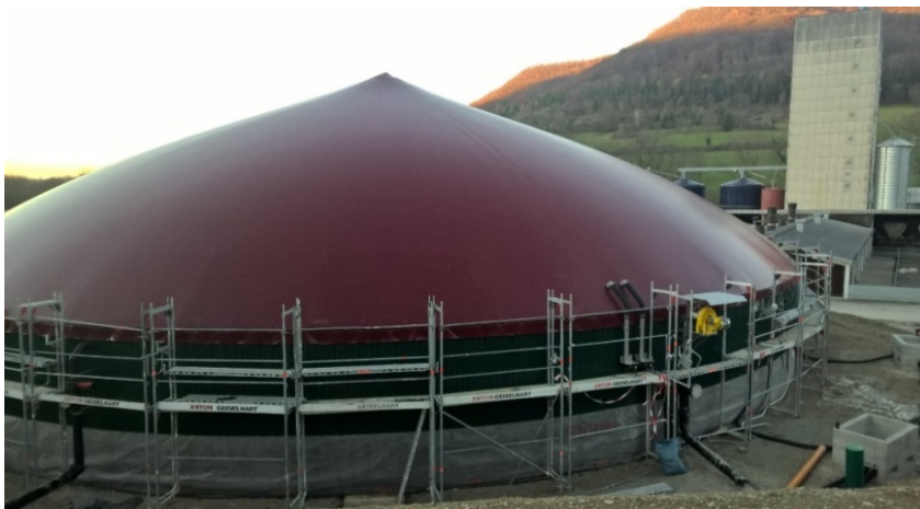
Das neue Gärrestlager während der Bauphase
