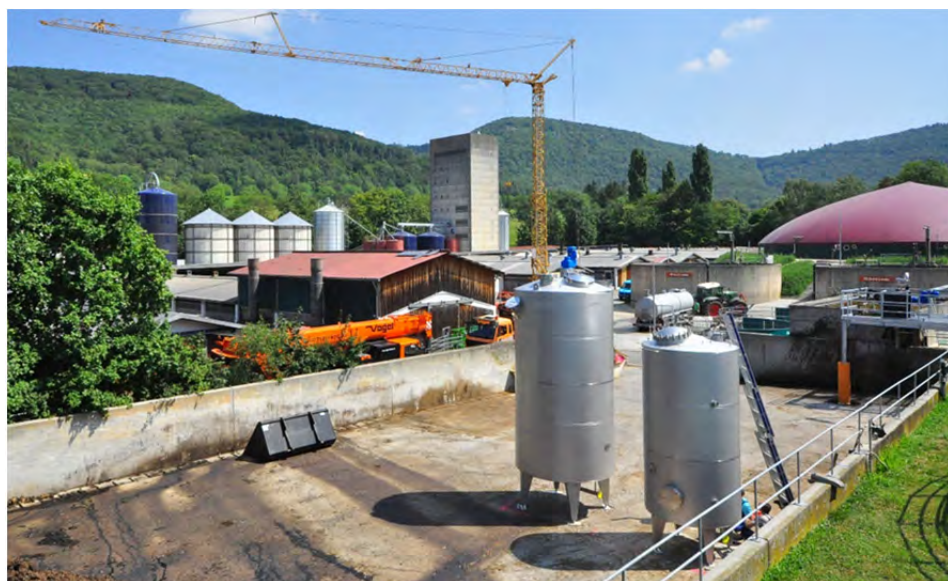
Aufstellung der Pilotanlage am Unteren Lindenhof (Merkle, 2018)
