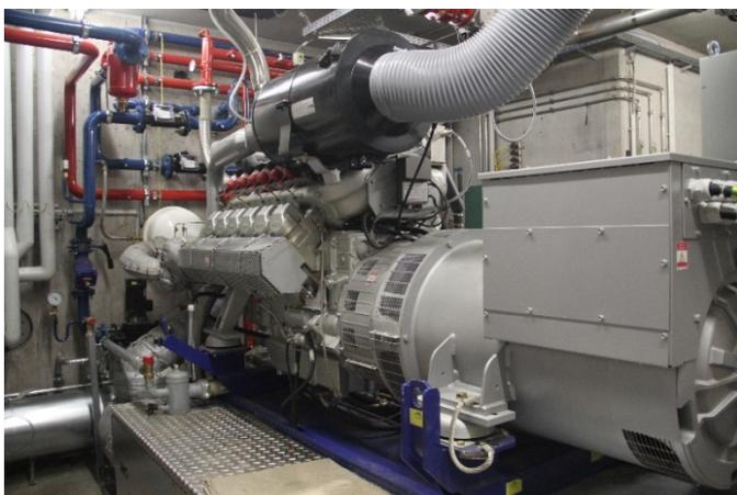
Neues Gas-Otto-BHKW an der Forschungsbiogasanlage mit einer elektrischen Leistung von 355 kW
